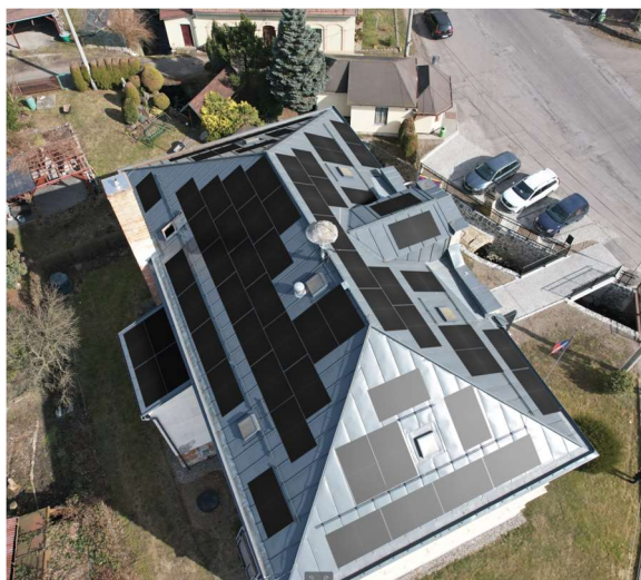
Náhled kompletního osazení střechy fotovoltaickými panely
