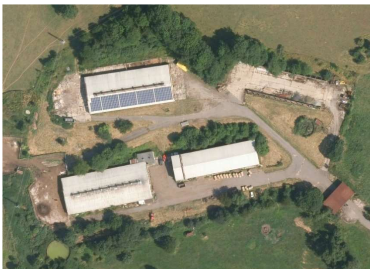
Obrázek: Instalovaná střešní FVE v Mistrovicích. Zdroj: mapy.cz
